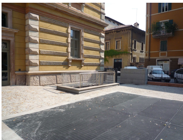
Scale che conducono alla centrale termica
